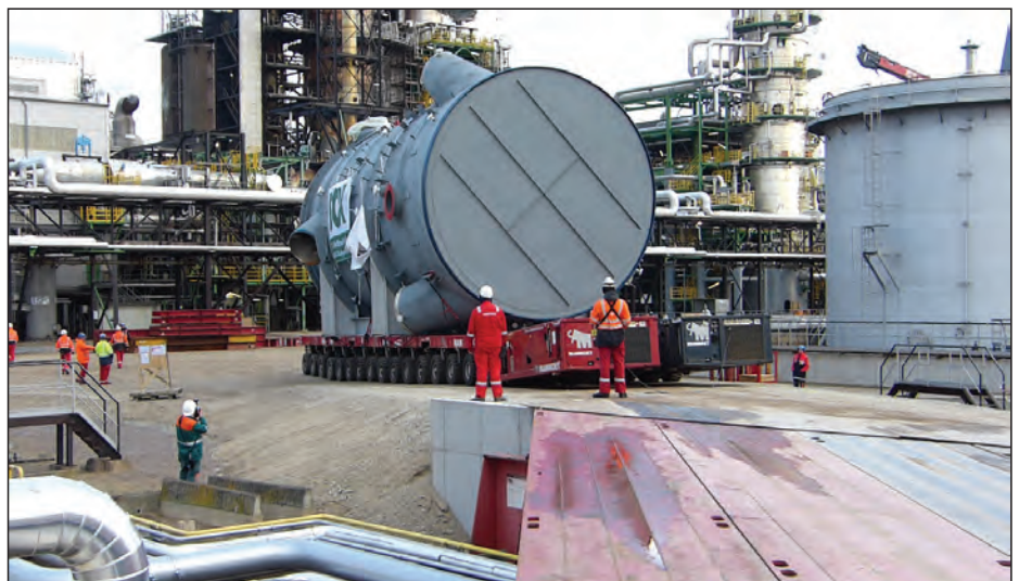
Transport eines Regeneratormoduls über die Behelfsüberfahrt
