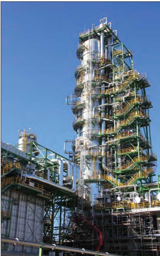
Die Montage der Kolonnen- und Treppenhausmodule der Rohöl1-Anlage kurz vor der Fertigstellung
