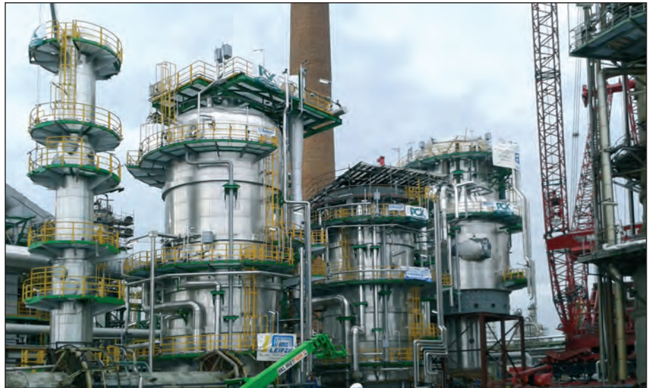
PCK-Stillstand 2016: Die vorgefertigten Kolonnenteile der Vakuumkolonne 1K6 vor der Montage
