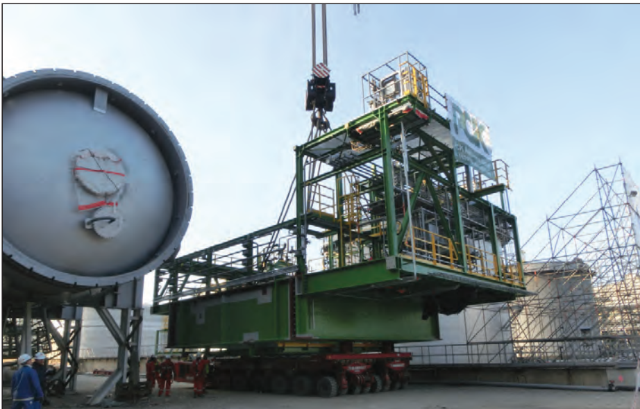
Vormontierter Regeneratortisch mit einem Gewicht von 168 t
