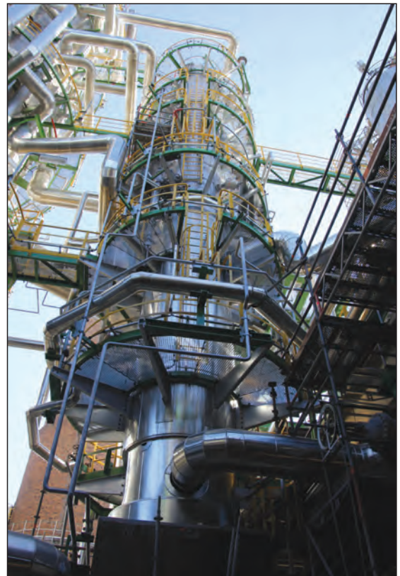
Bereits montierte Stripperkolonne 1K3 in der Rohöl1-Anlage
