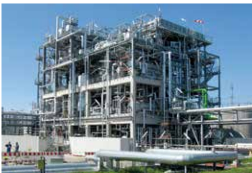
Propanentasphaltierungsanlage (PDA), H&R Ölwerke Schindler GmbH, Hamburg, Deutschland, 2011
