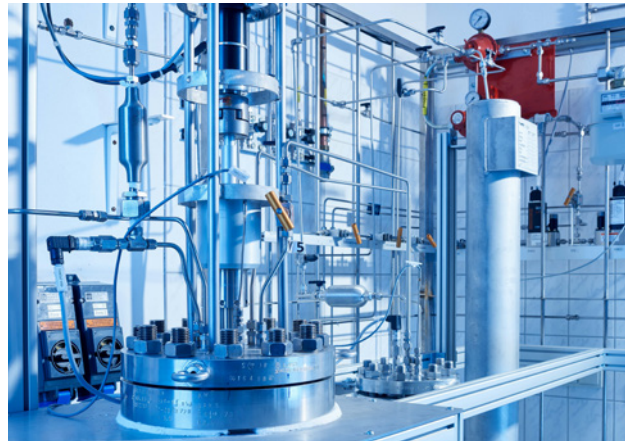
Pilotanlage der EDL in Leipzig, Deutschland
