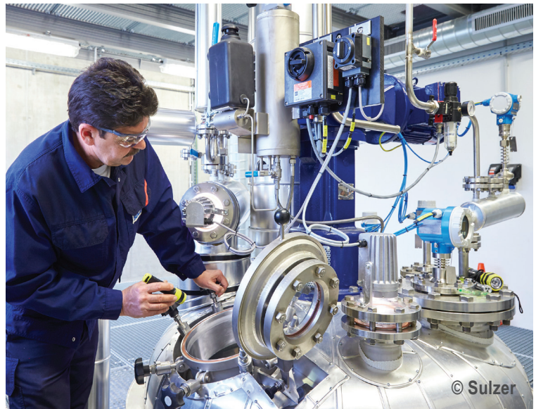
Sulzer-Versuchsanlage für lösungsmittelfreies Verfahren
