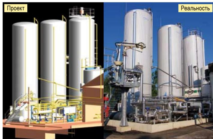
**Новые пути в планировании:** впервые в Линце использовалась компьютерная программа PDMS для планировки оборудования, трубопроводов и электрической части. Благодаря этой программе с пластичным и близким к реальности изображением детали обсуждения проходят невероятно эффективно. Уже на стадии планирования желания клиента точно схвачены, таким образом сооружение установок происходило без существенных издержек и изменений.
