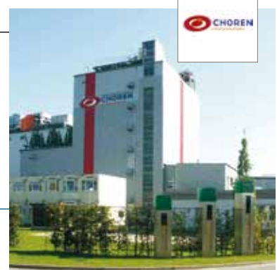
Biodiesel-Anlage der 2. Generation für CHOREN zur Herstellung von synthetischem Kraftstoff aus Biomasse nach dem Carbo-V®-Verfahren
