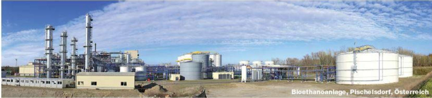
AGRANA Bioethanol GmbH errichtete Österreichs größte Bioethanolanlage. Der aus landwirtschaftlichen Rohstoffen hergestellte Alkohol wird Benzin zugemischt. Als Generalplaner betreute Pörner sämtliche ingenieurtechnischen Bereiche, wie Bauplanung, Statik, Stahlbau, verfahrenstechnische Anlagenteile, Rohrbau inklusive Isometrien, EMSR sowie Baustellenorganisation und Bauaufsicht.
